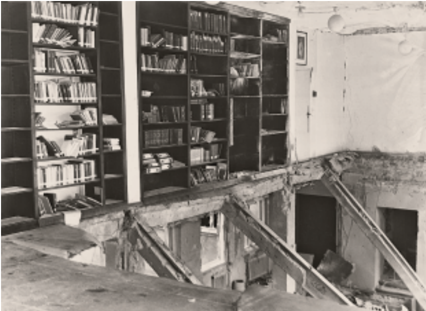
Bei einem verheerenden Bombenangriff Anfang Februar 1945 wurden die Gebäude der DGZ weitgehend zerstört.
